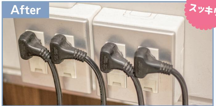
コンセントボックスを設置し、定格アンペア数を超えず安全に！
