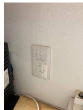
LAN配線敷設
